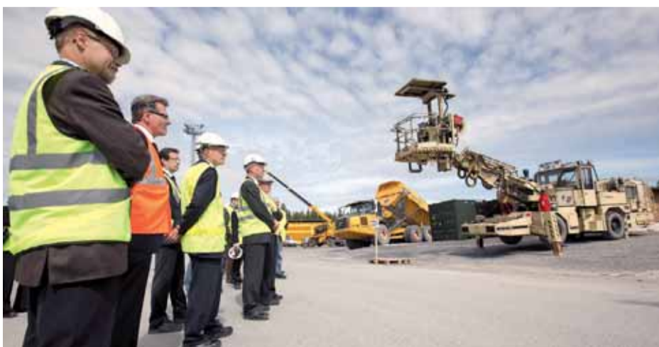
ONKALO-työmaalla vieraat pääsivät näkemään koneita, joita käytetään ONKALON louhinnassa.
